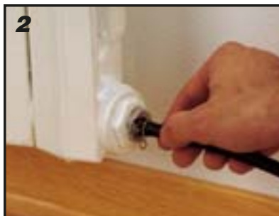
2 Aparafusar o tubo de descarga.
