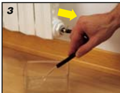
3 Extrair o tubo, orientando-o para uma bacia.
