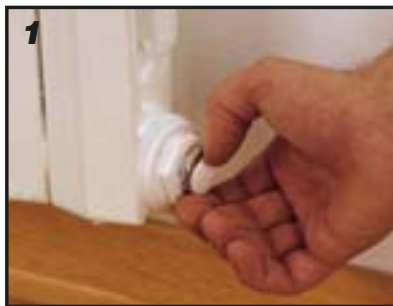
1 Retirar a tampa de protecção.
